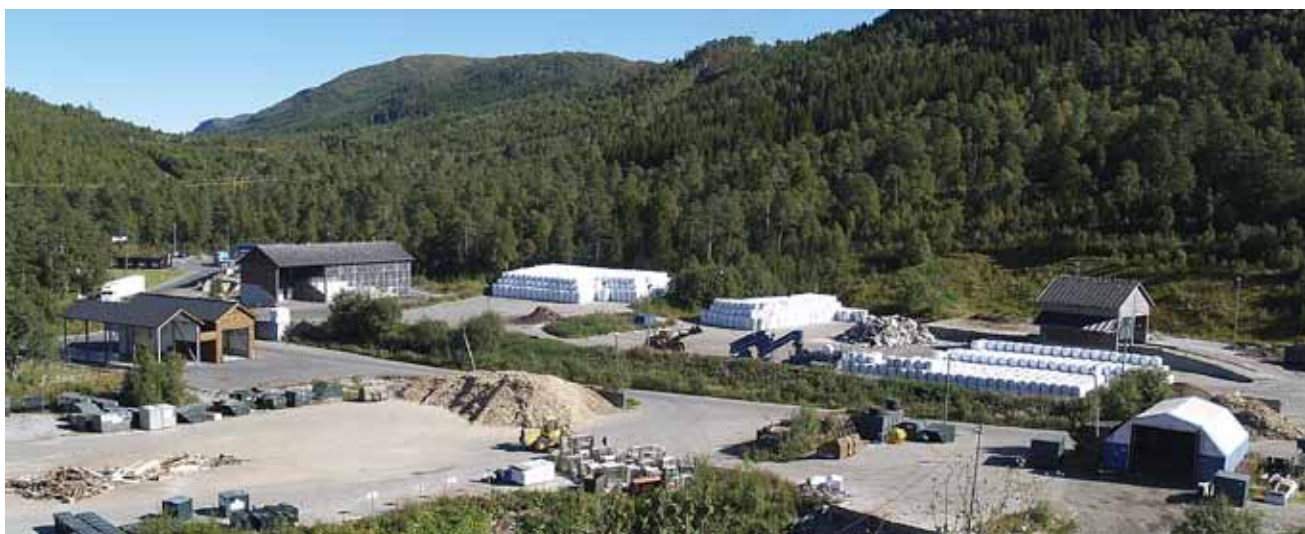
RIR-anlegget sett fra toppen av deponiet i september 2010. Den store plassen midt i bildet brukes nå til kverning, pakking og mellomlagring av restavfall. Helt til venstre ligger anleggets nyeste bygning, vaskehallen som åpnet i 2009. Bak vaskehallen ser vi mellomlageret for matavfall som skjuler for miljøstasjonen. Helt bak ligger administrasjonsbygget.
